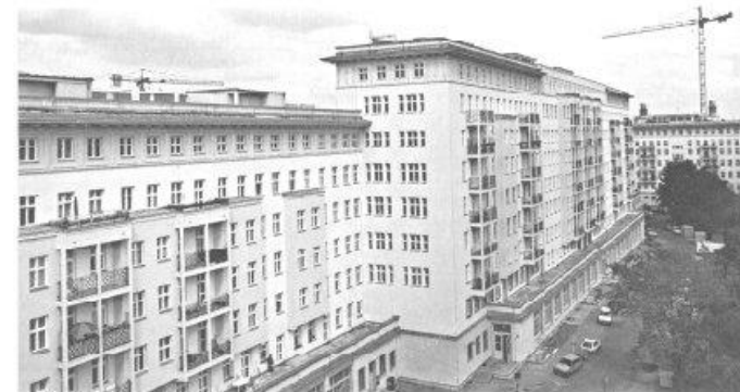
B47: Abschnitt C, rückwärtige Fassadenseite nach der Sanierung, Richard Paulick
