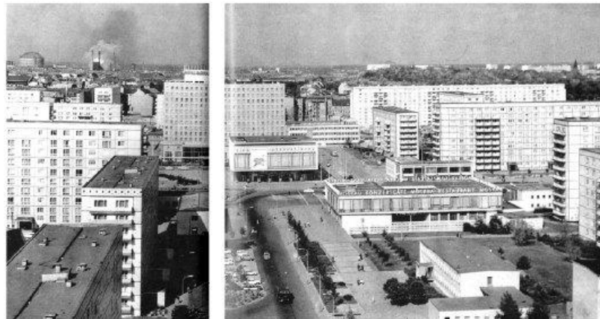
B35: Wohnkomplex Stalinallee, 2.Abschnitt
