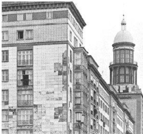
B39: Abschnitt F- Nordseite, Eckbaukörper, Karl Souradny
