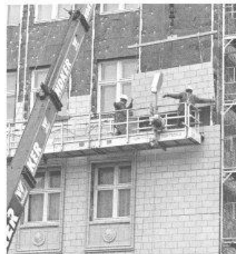
B43: Abschnitt C- Südseite, Richard Paulick Befestigung der Trägerplatte
