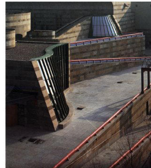
B21: Ausschnitt der Frontfassade, obere Terrasse
