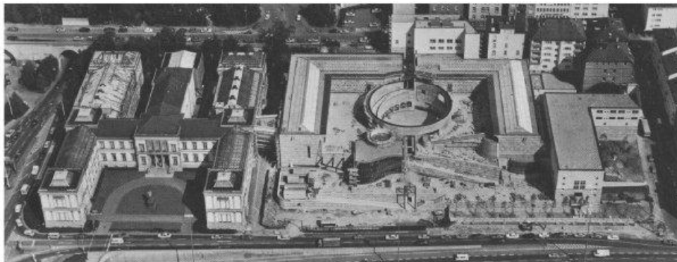
B20: Alt- und Neubau der Staatsgalerie
