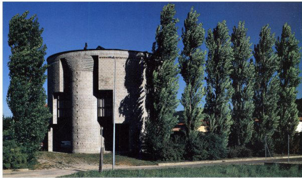
B19: Halbrund des Treppenhauses
